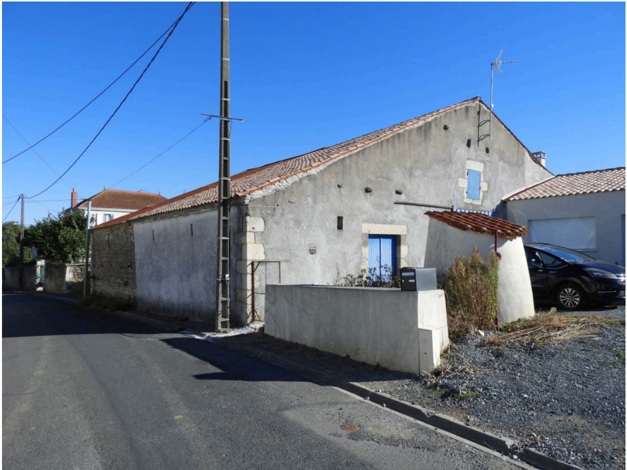
La grange-étable et le puits coiffé vus depuis le sud-ouest.
