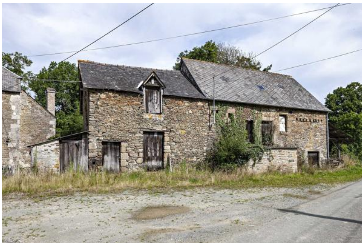
Bâtiment nord, vue depuis l'est.
