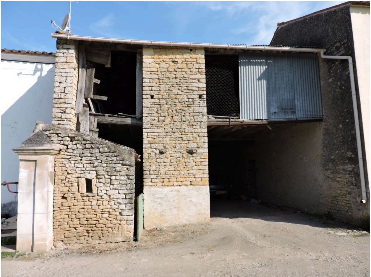
L'écurie et le fenil dans le prolongement sud-ouest de l'ancien hôtel, vus depuis le sud-est.
