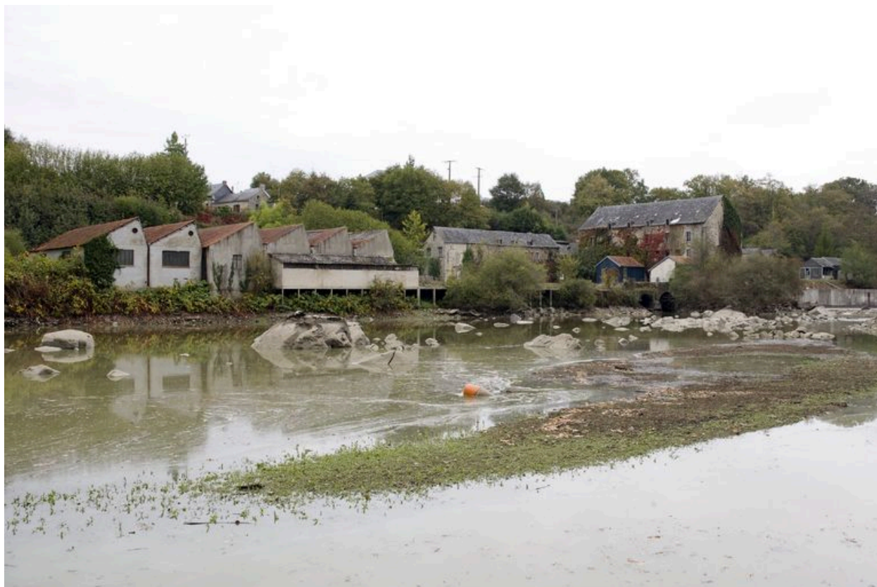
Vue d'ensemble de l'ancienne usine depuis la rive gauche en aval, pendant les écoures de 2009.
