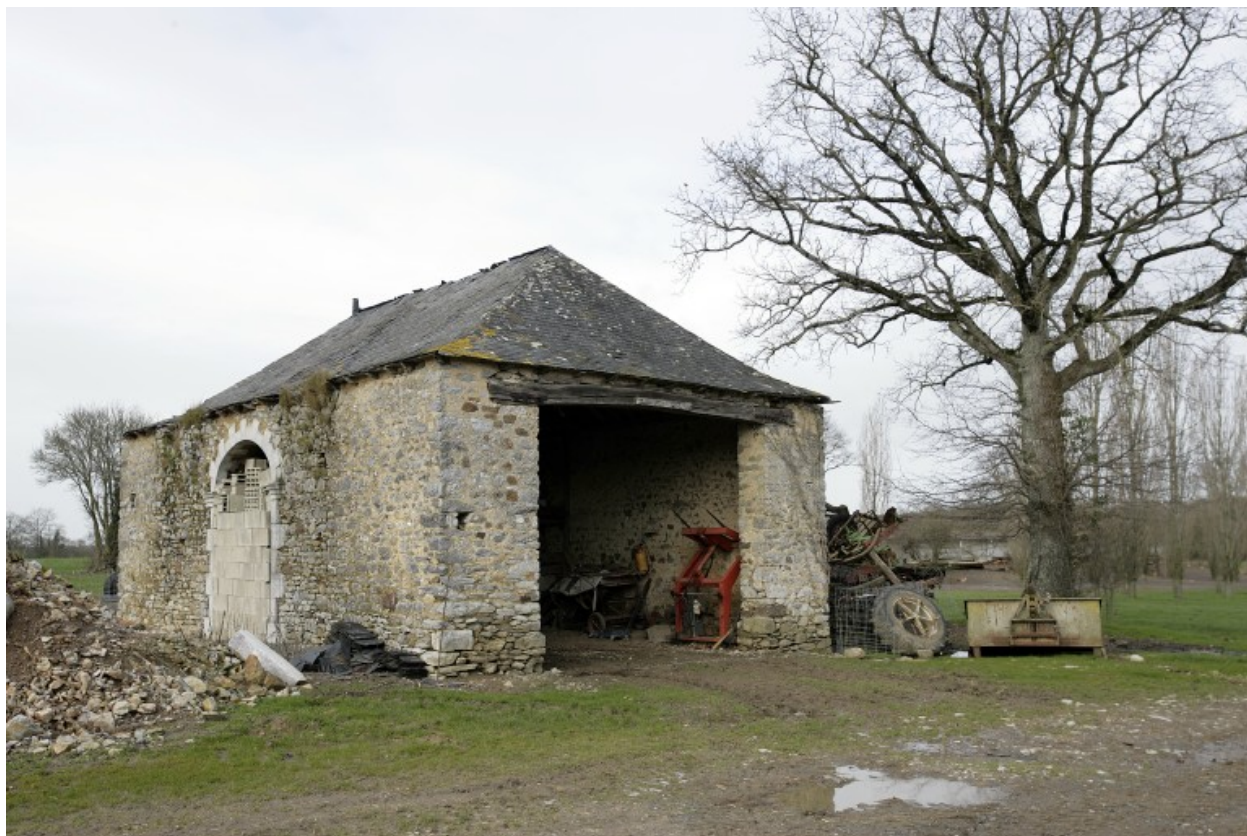
La remise vue depuis le sud-est.
