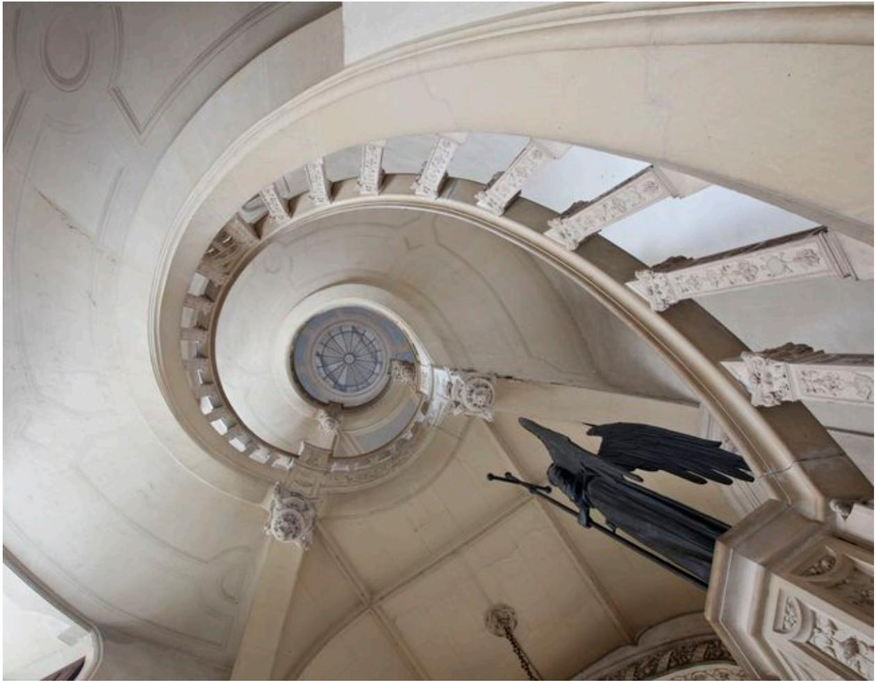
Tour nord-ouest : escalier en vis suspendu avec éclairage zénital.
