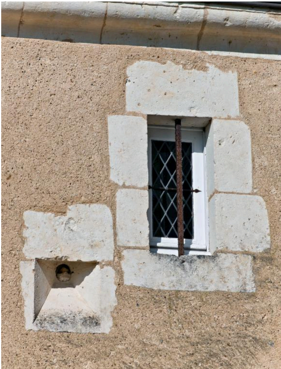
Pavillon d'angle sud-ouest bastionné : détail de la baie à l'étage et de la bouche à feu, face est.
