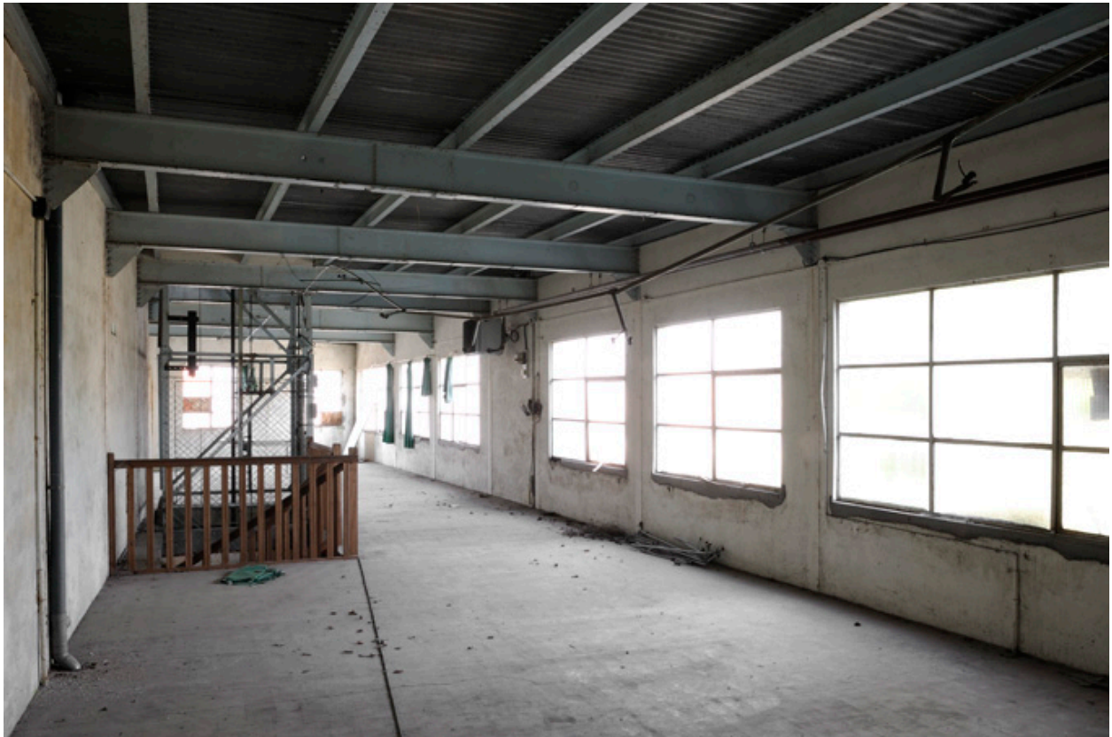
Vue intérieure (1er étage) du bâtiment construit en 1948.
