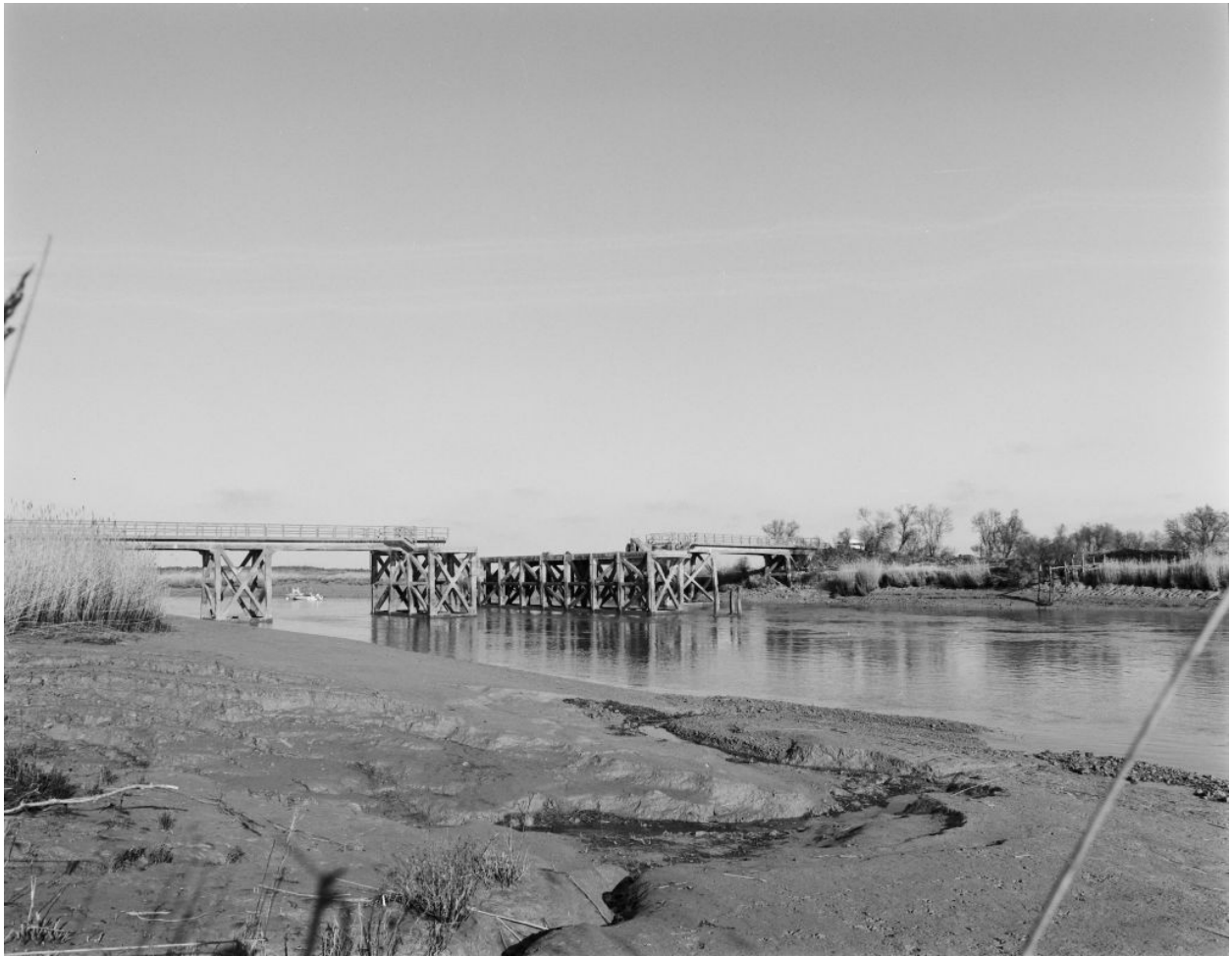
Le pont, privé de sa travée mobile centrale, vu depuis l'aval en 2000.
