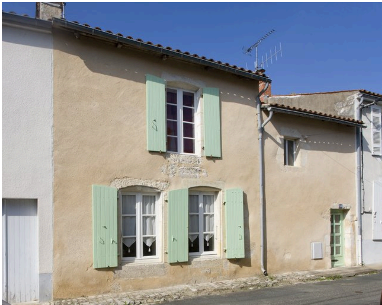
Maison 14, rue du Petit-Pavé, constituée de deux corps de bâtiment, remodelée après 1784 pour Melle Brethé de la Guibretière.
