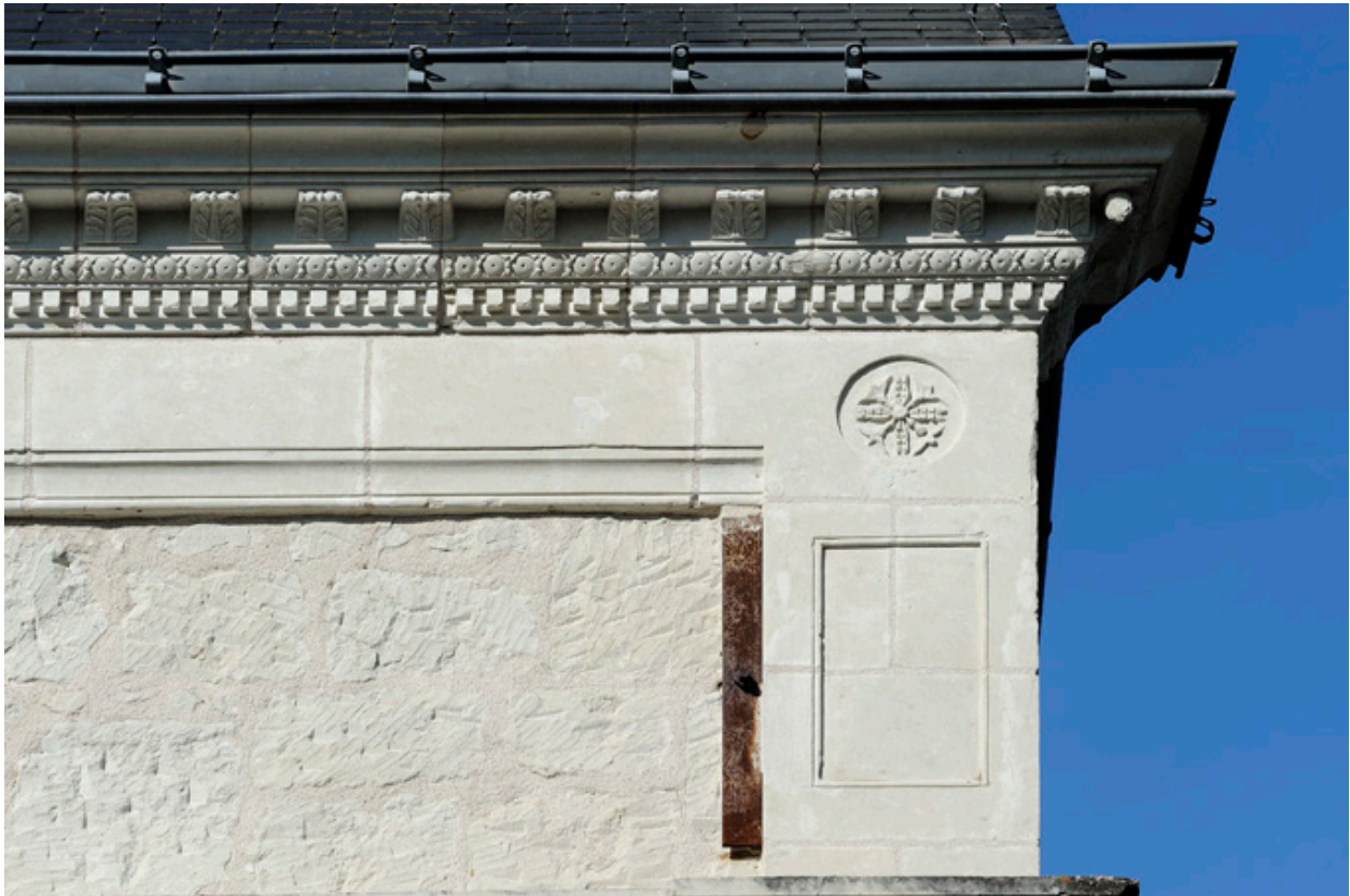
Détail de la corniche
