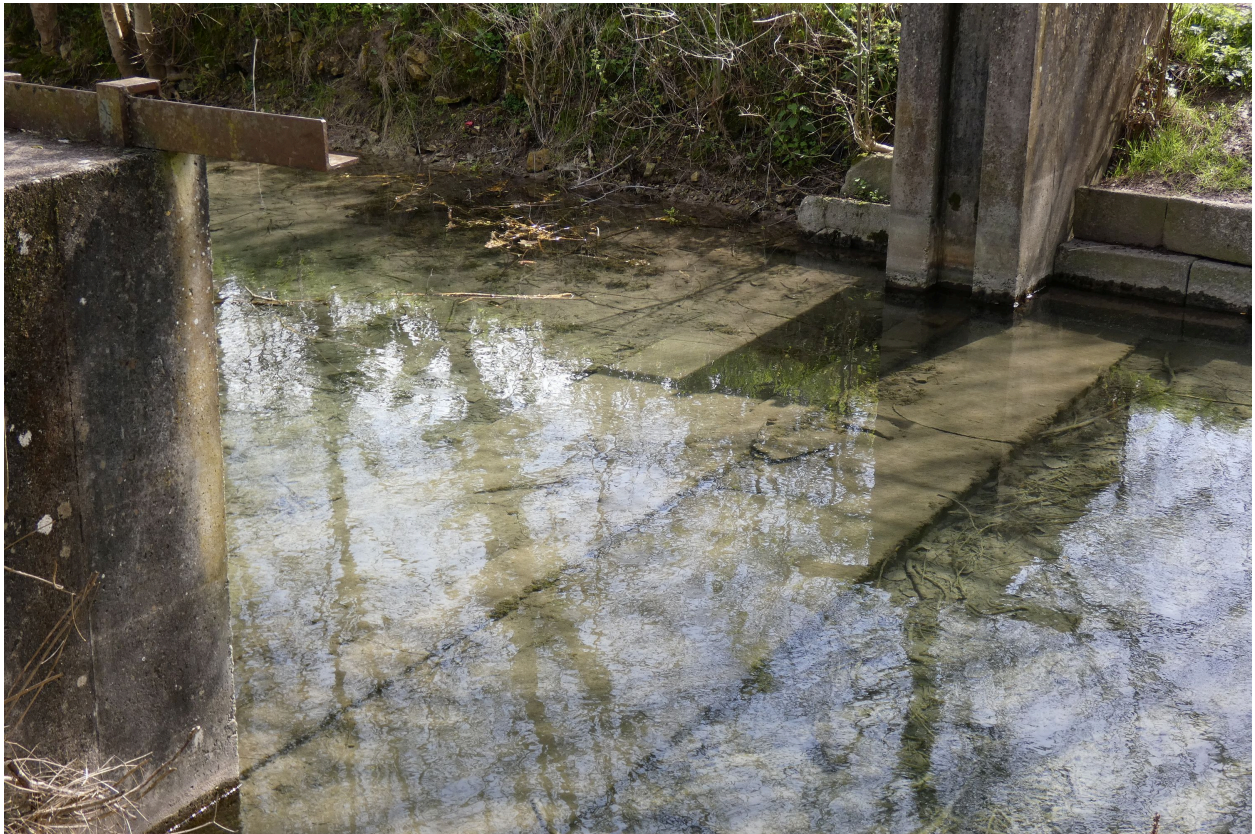
Le radier du barrage mobile.
