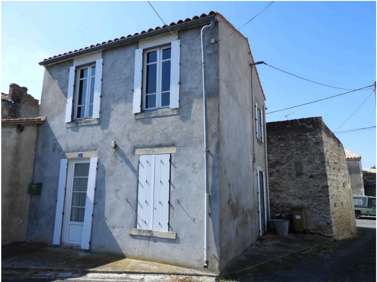
Maison attenante, à deux travées d'ouvertures, 11 rue du Retour.
