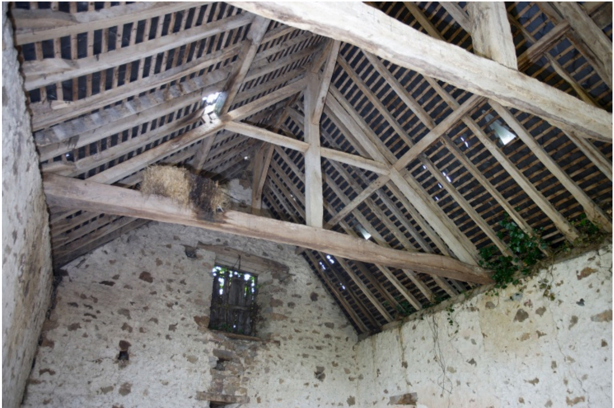
L'étable ouest : la charpente vue depuis le nord.
