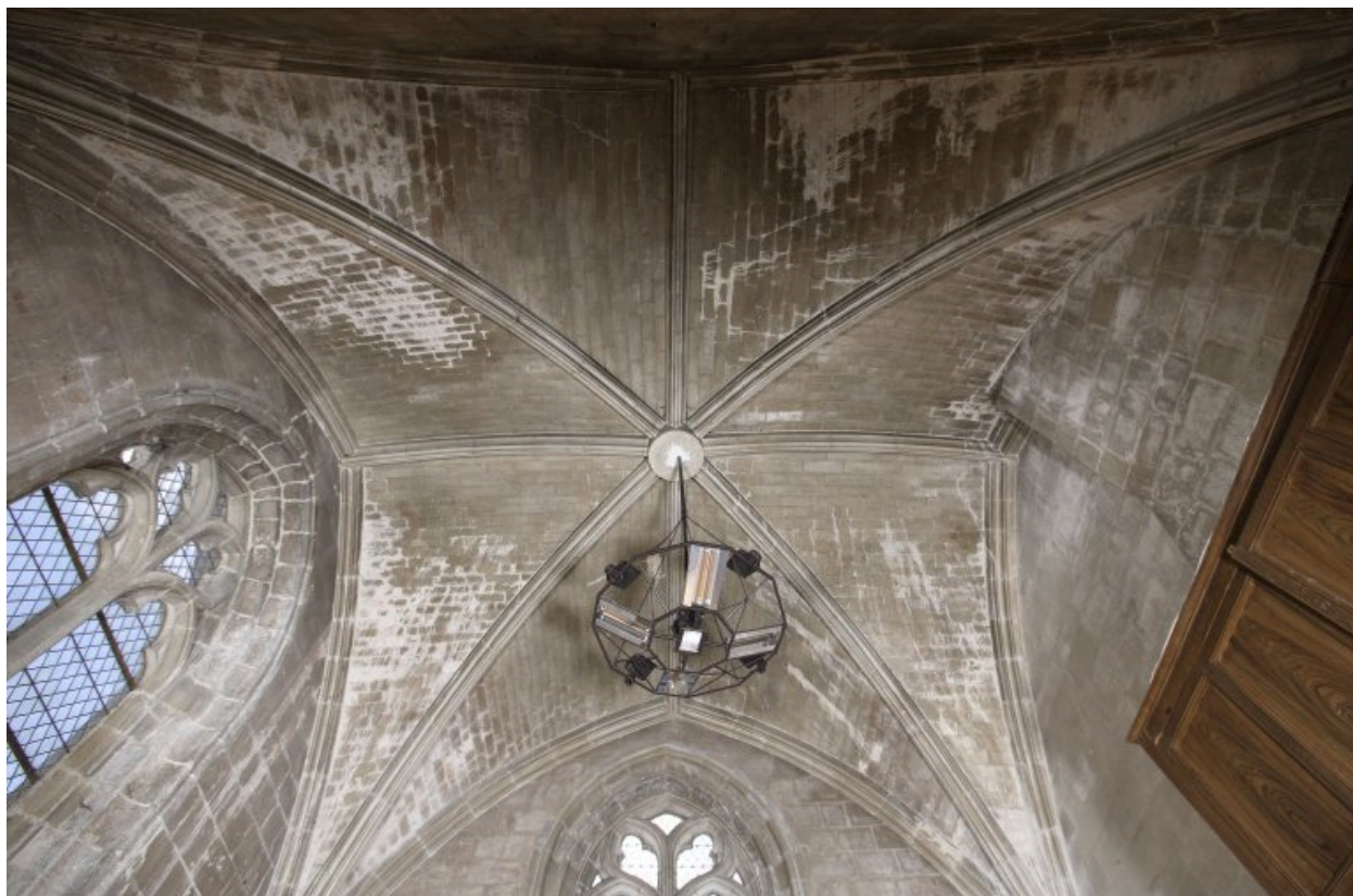
Voûte de la sacristie.
