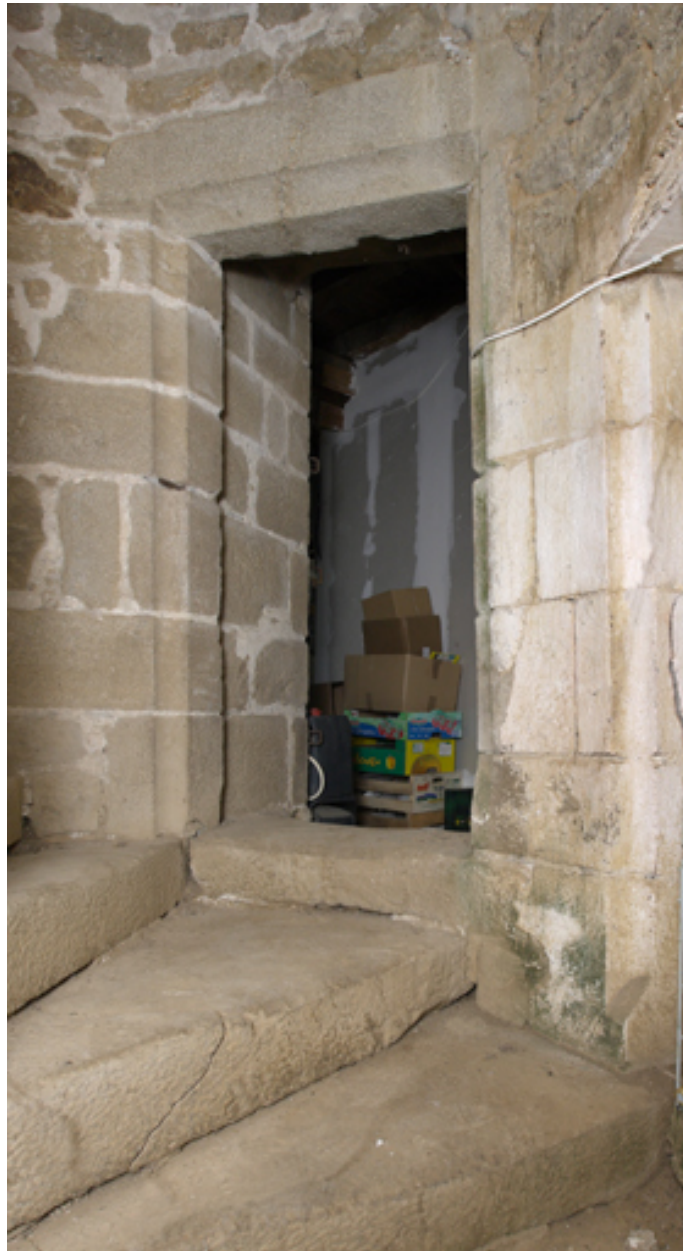
Logis. Tour d'escalier. 2e niveau. Porte d'accès à la salle est.
