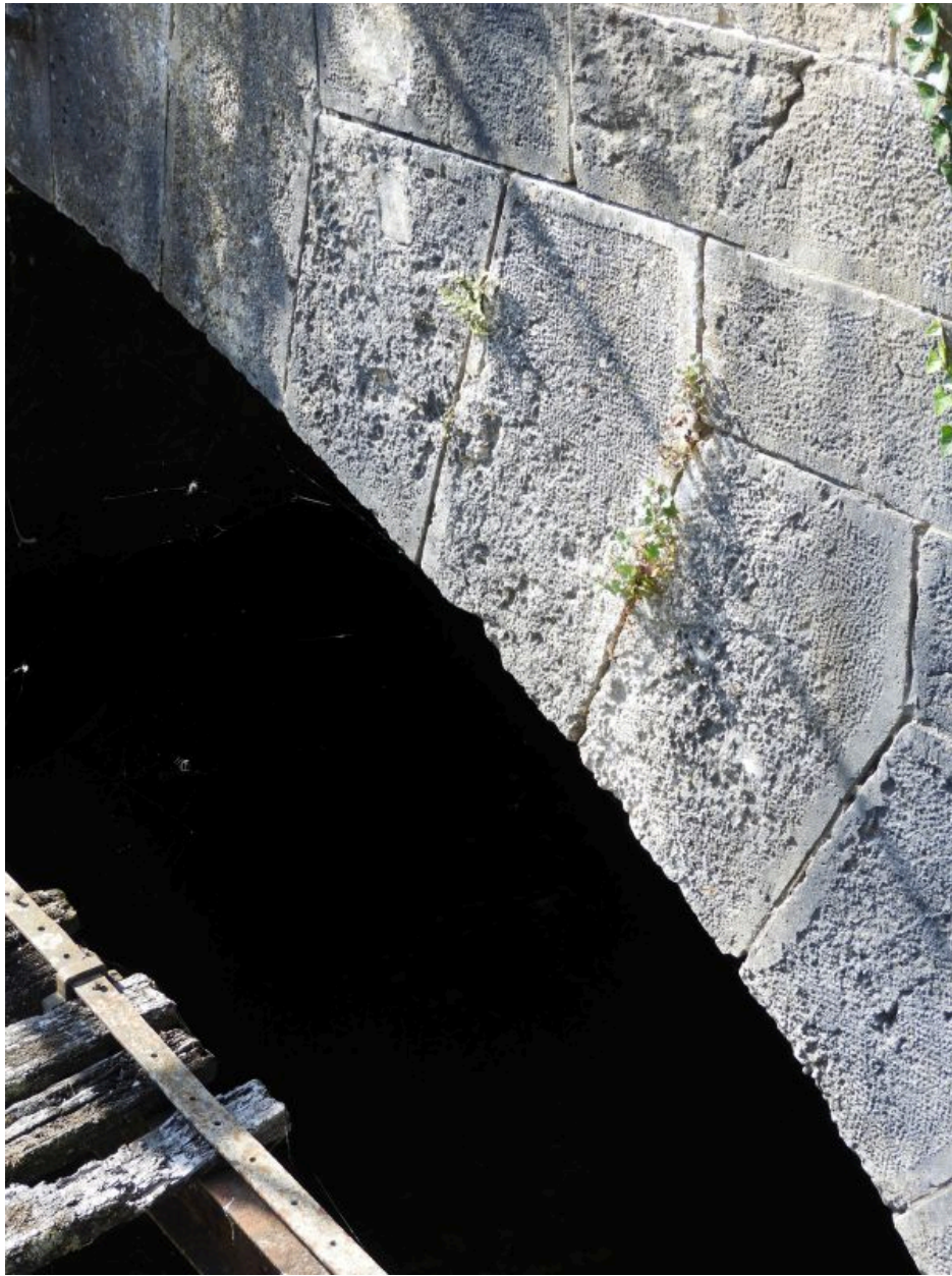
Détail de la maçonnerie du pont enjambant l'aqueduc côté amont : claveaux réguliers.
