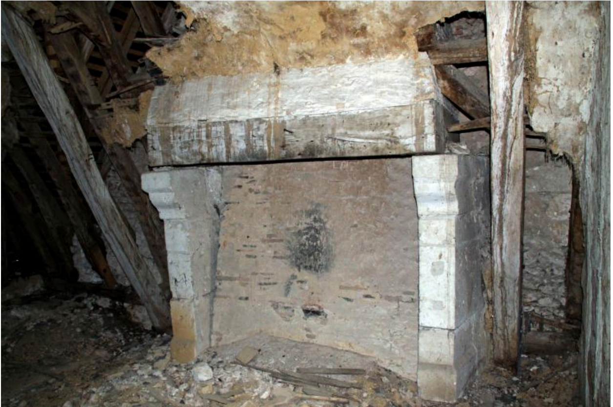
Comble du corps central : cheminée.
