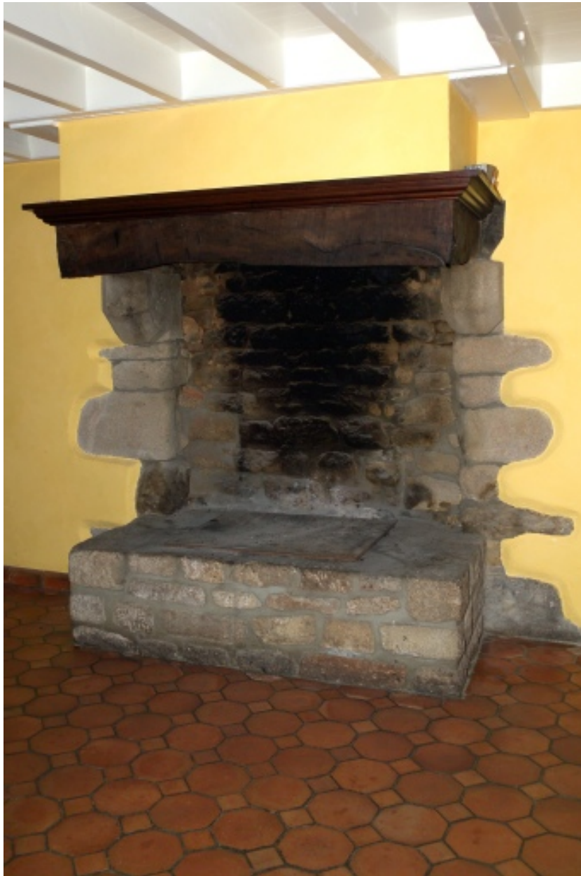
Cheminée de la partie ouest.
