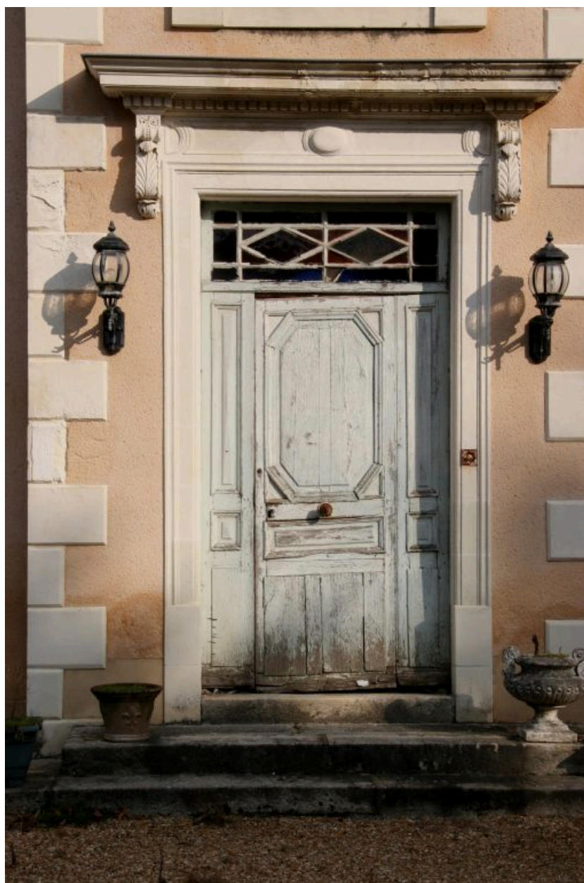
Façade antérieure sur cour : la porte d'entrée.
