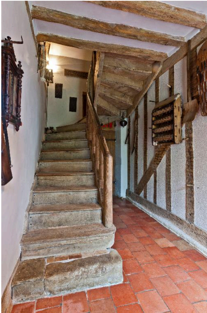
L'escalier vu du rez-de-chaussée.
