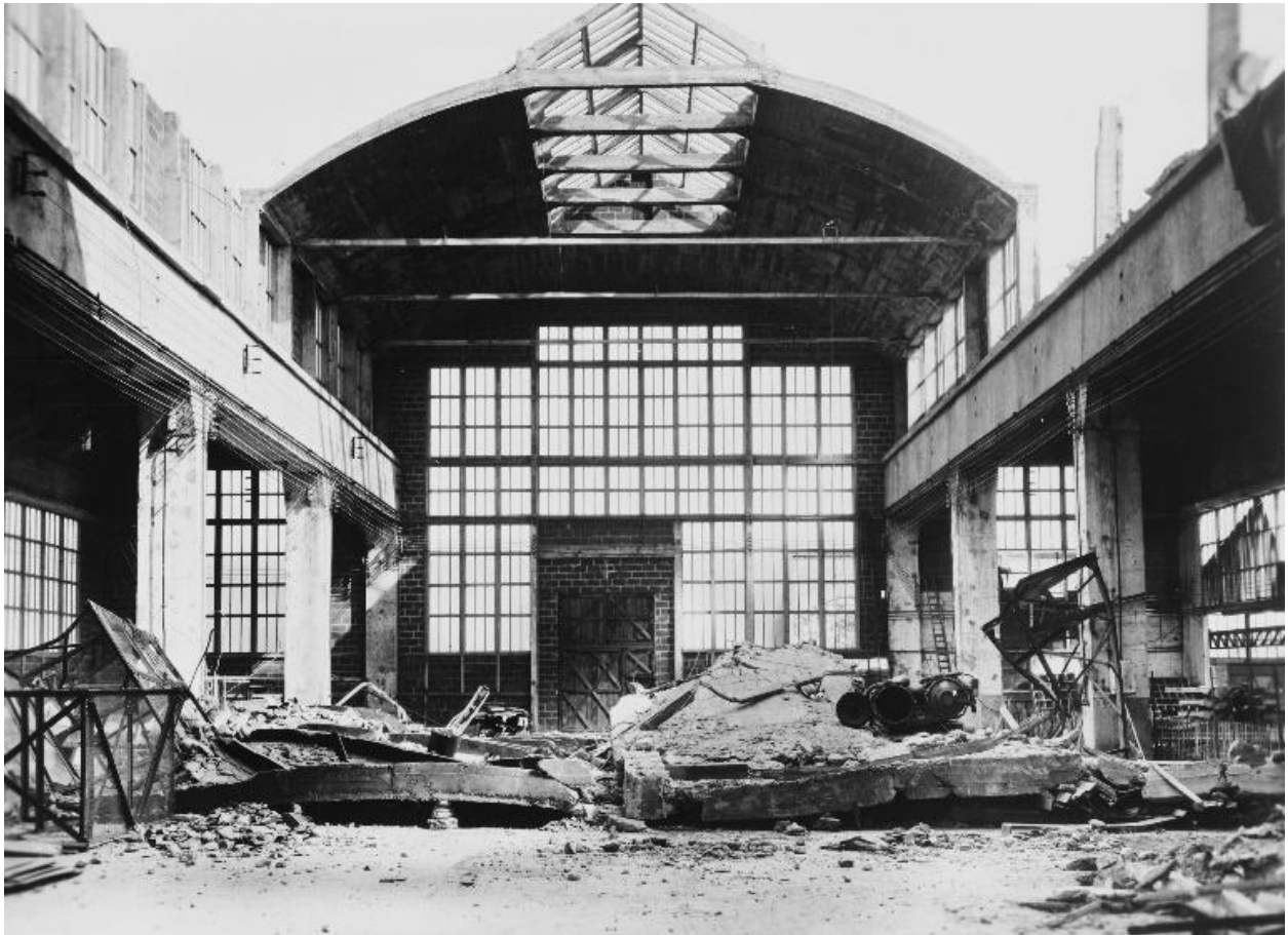
Atelier F, après l'effondrement de 1947.
