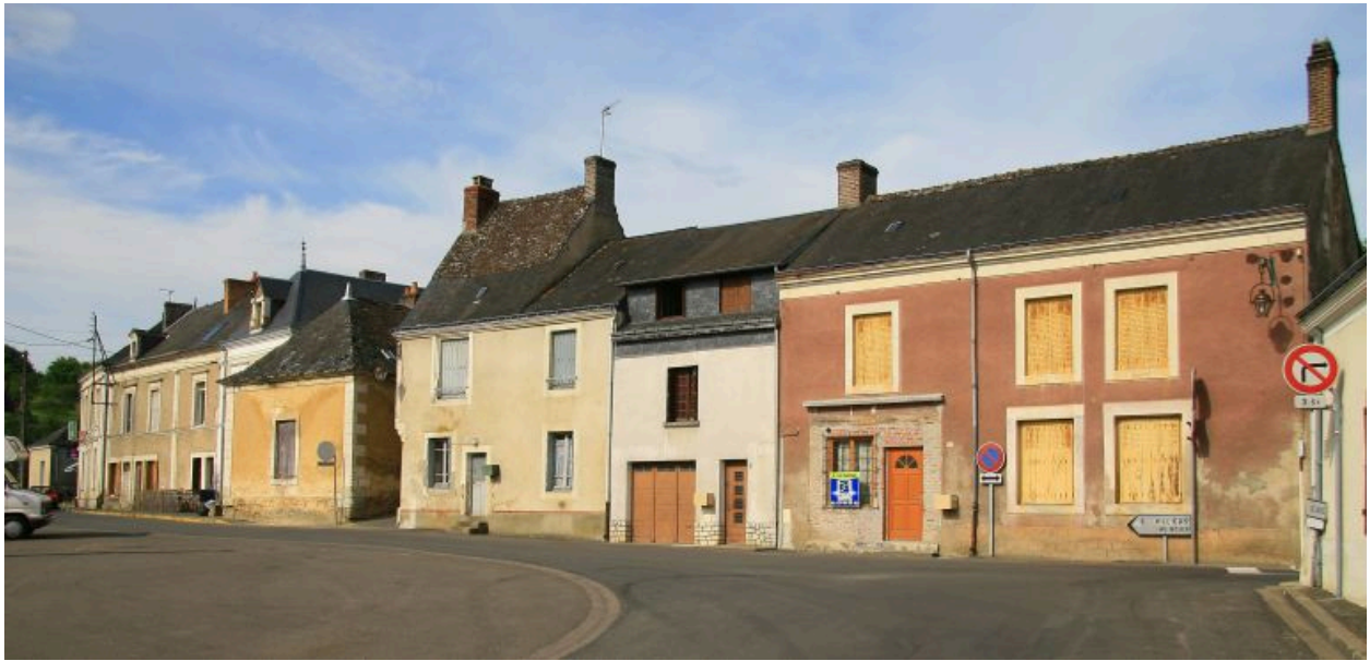
Vue d'ensemble de la rive de la rue du Commerce.
