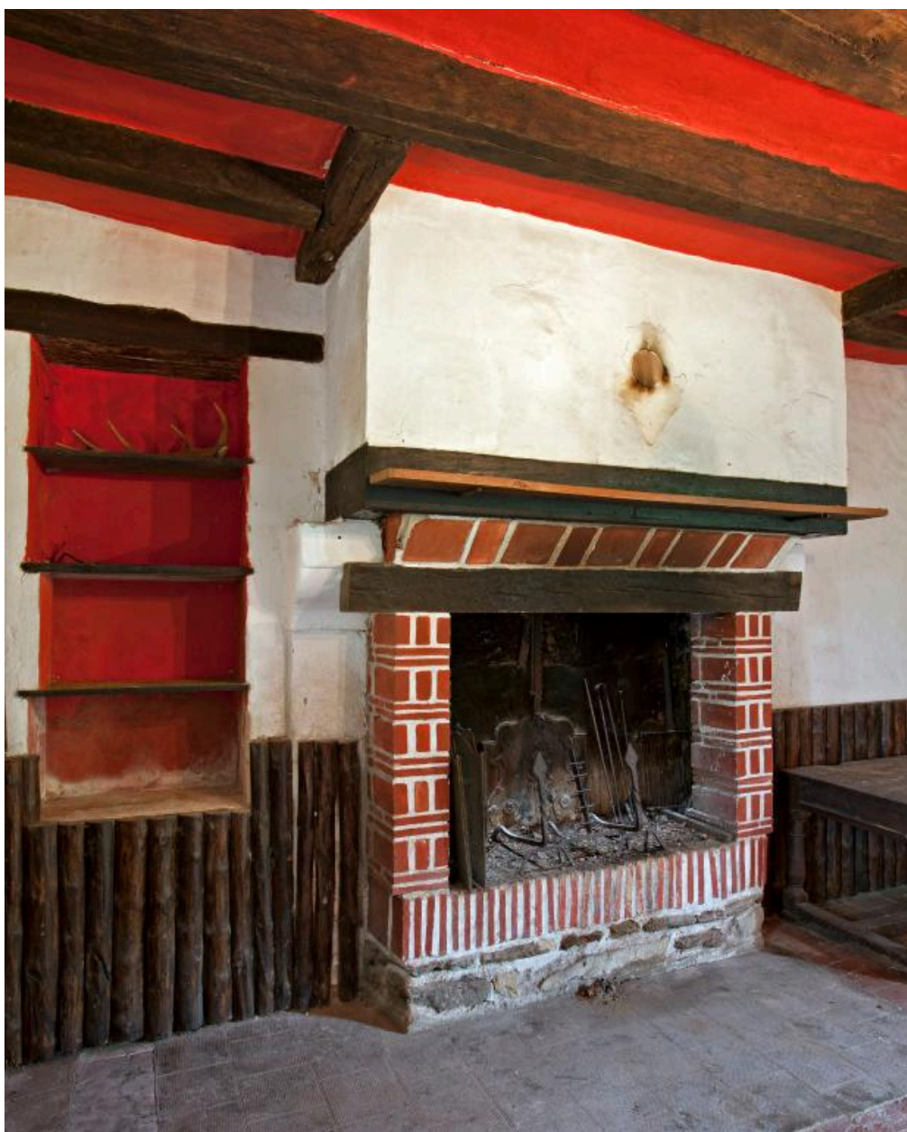
Chambre à feu ouest : placard mural et cheminée (refaite).
