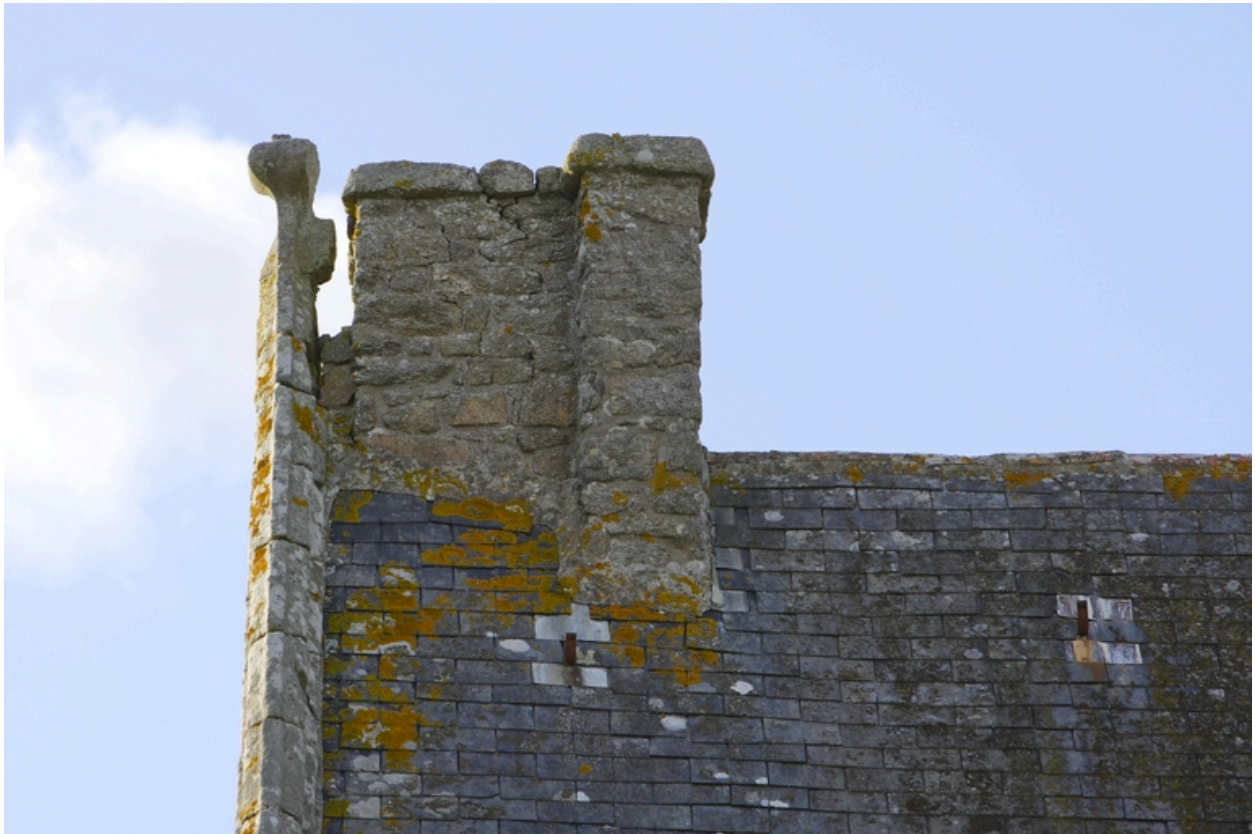
Logis. Aile est. Pignon sud. Détail de la souche de cheminée.
