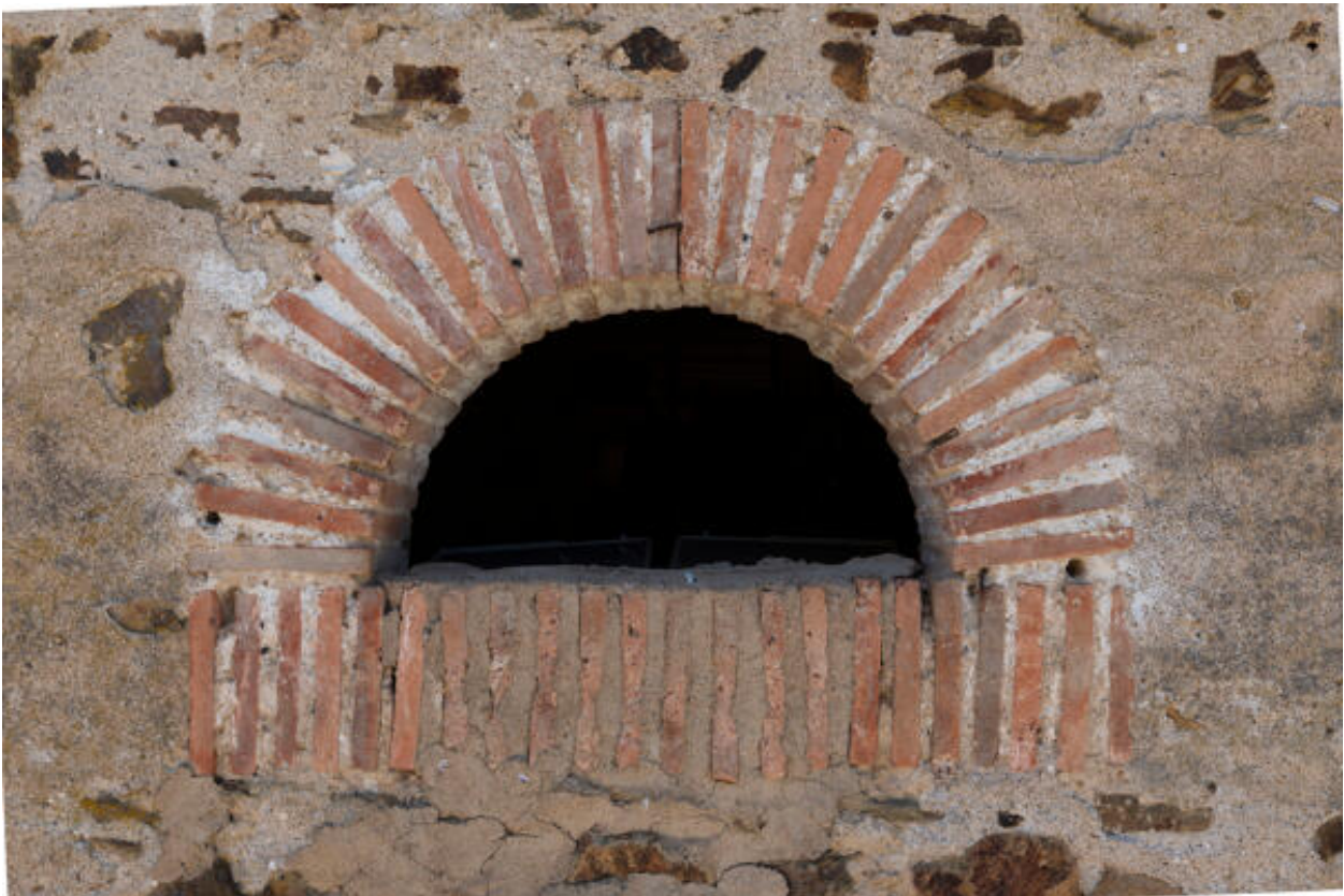
L'ancienne écurie, détail d'une baie.
