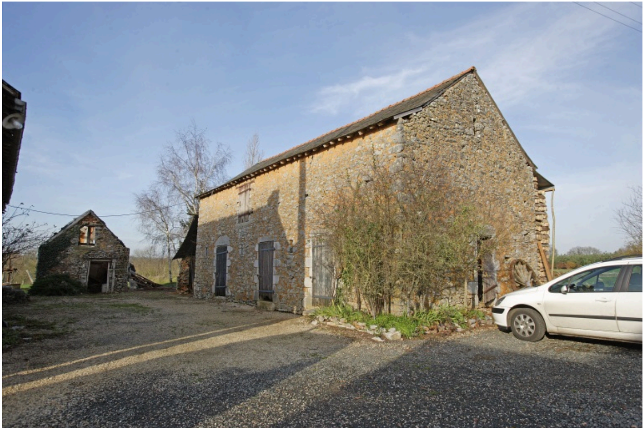
La porcherie et la première étable-grange vus depuis le sud-est.
