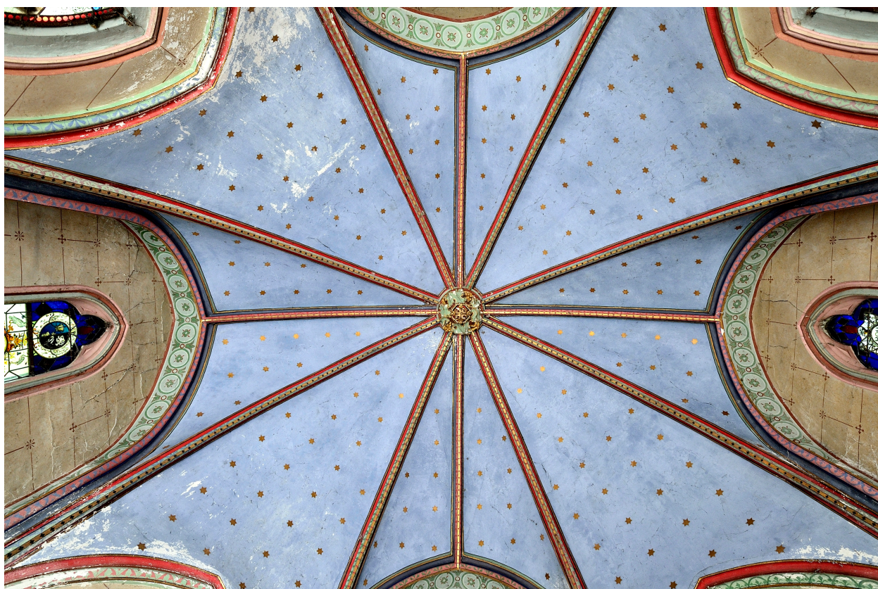
Chapelle. Vue de la voûte.
