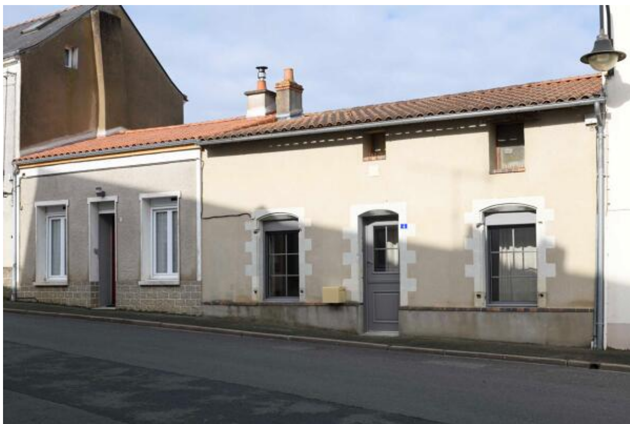
Vue d'ensemble du 4 et 6 rue de la Houssaye, Saint-Laurent-du-Mottay.
