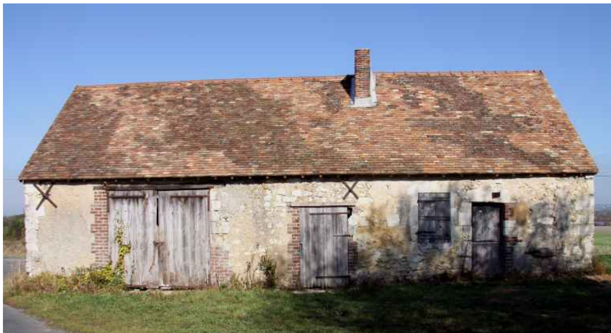
La maison n° 1 : façade sur cour.
