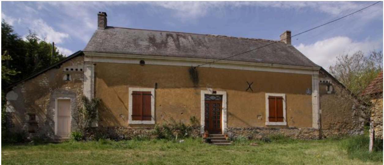
Maison à deux pièces à cheminée. La Basse Hugerie.
