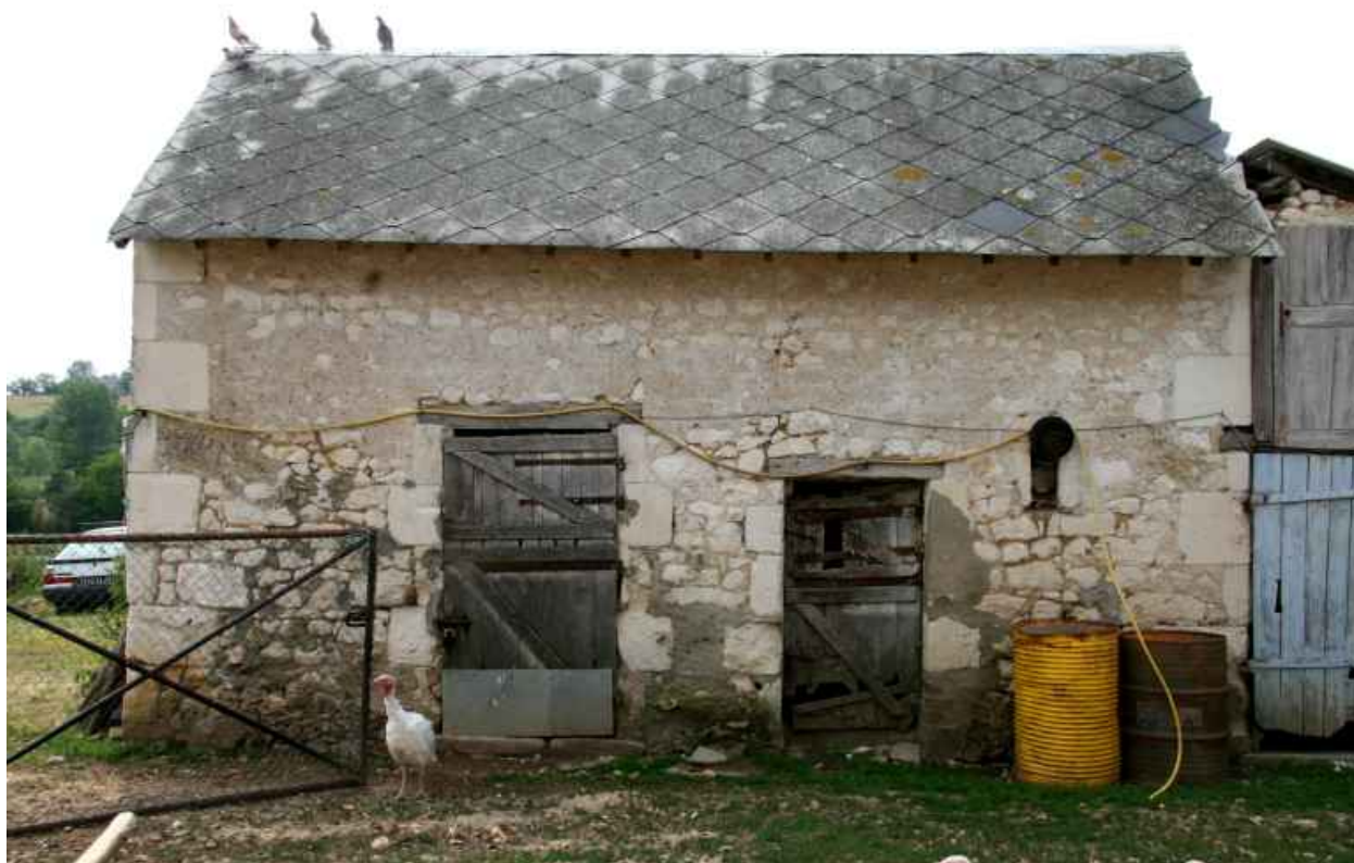
Toit à porcs construits entre 1811 et 1845.
