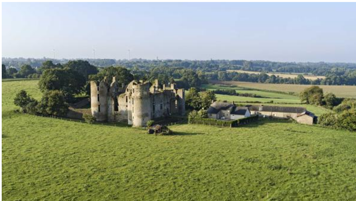
Vue aérienne du château du Bois-Thibault.
