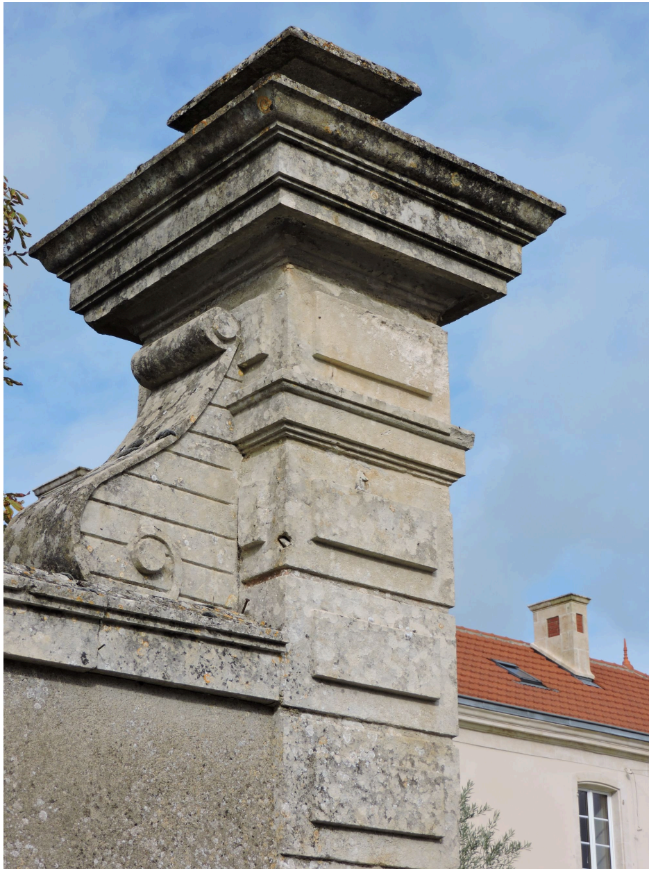
Détail d'un des piliers du portail.
