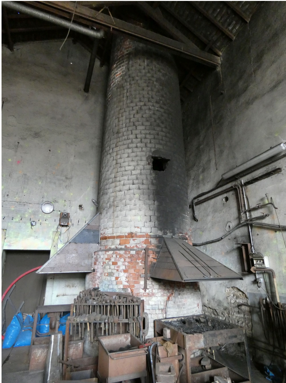
La base de la cheminée dans l'angle nord-ouest de la chaufferie.
