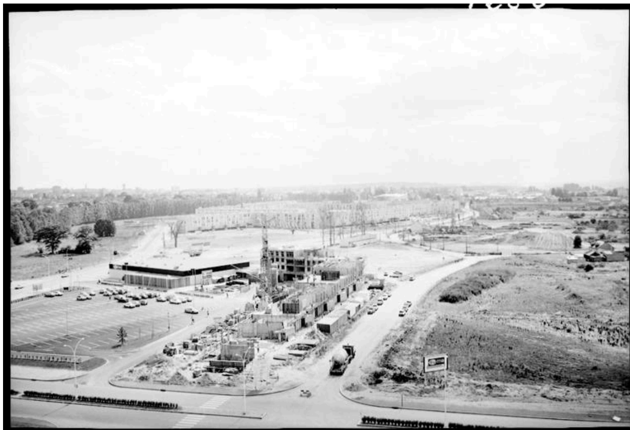
Vue du chantier de la galerie marchande, 1968.
