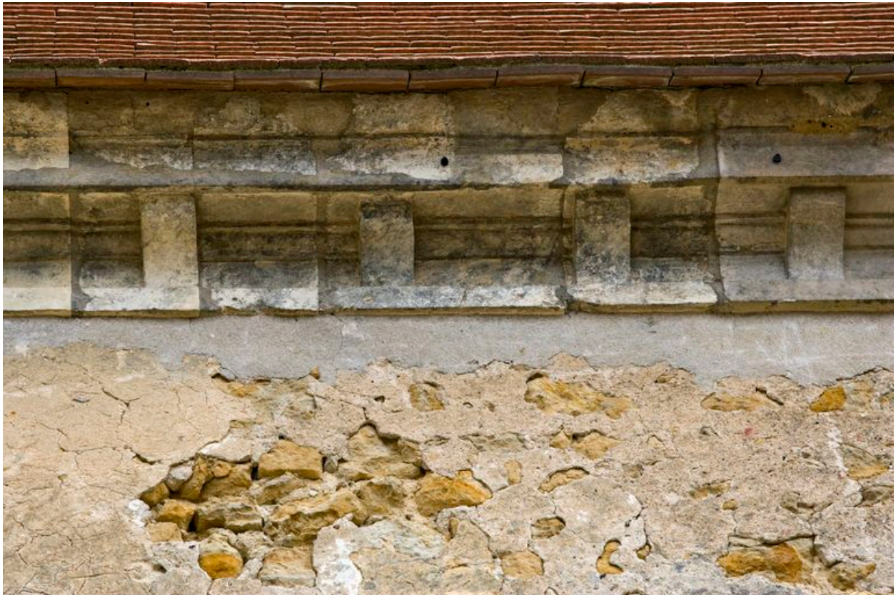
Corniche du mur ouest du bas-côté sud
