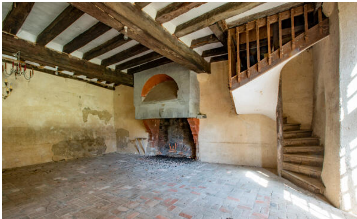
La grande salle du rez-de-chaussée.
