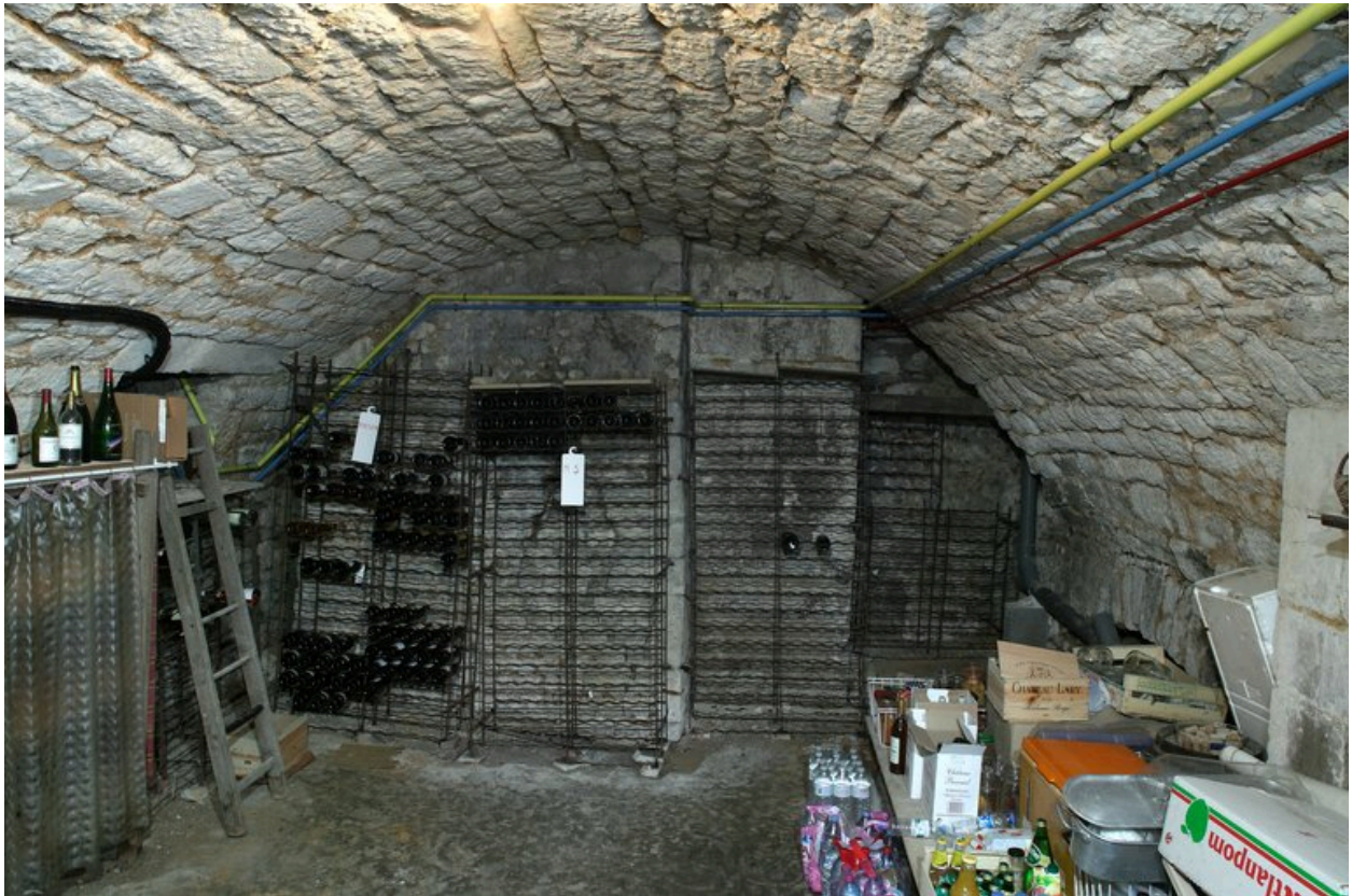
Vue du sous-sol, situé sous la cuisine, dans le bâtiment est.
