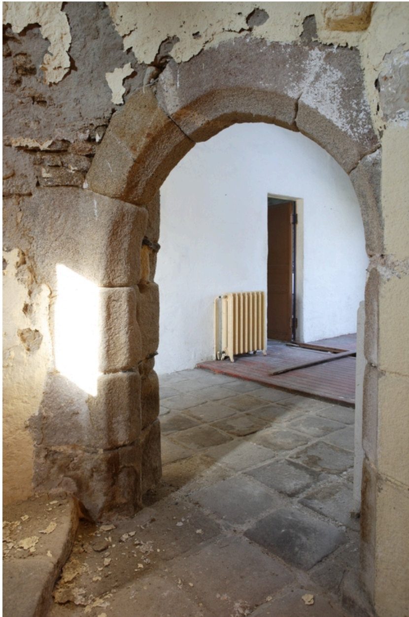
Tour d'escalier. Détail de la porte d'accès à l'escalier.
