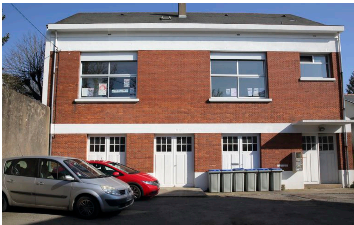
Ancien bâtiment des télégraphes.
