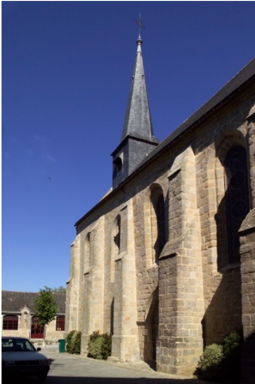
Mur sud et flèche vus depuis le sud-est.
