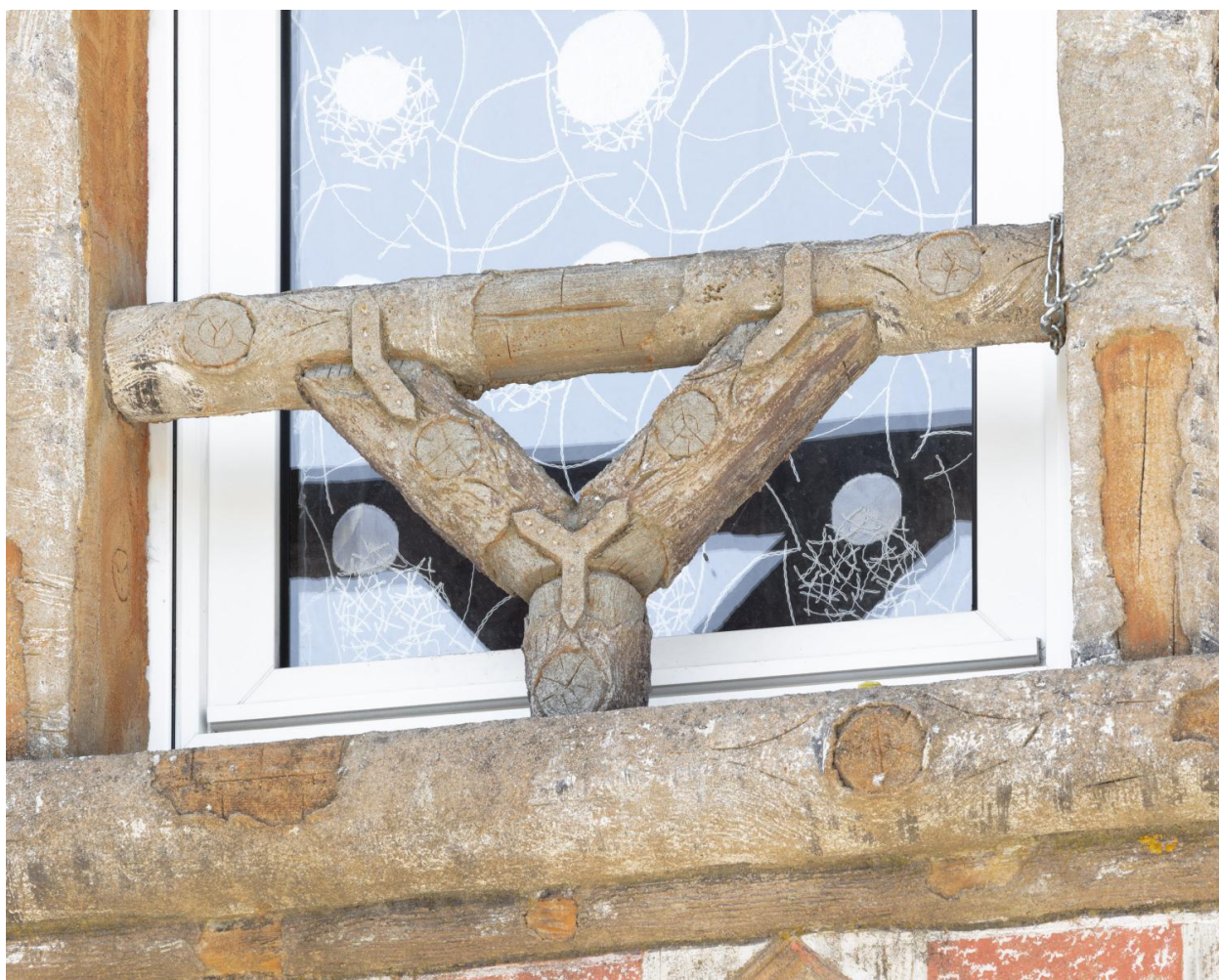
Vue d'une rambarde de fenêtre du premier étage sur la façade sud.
