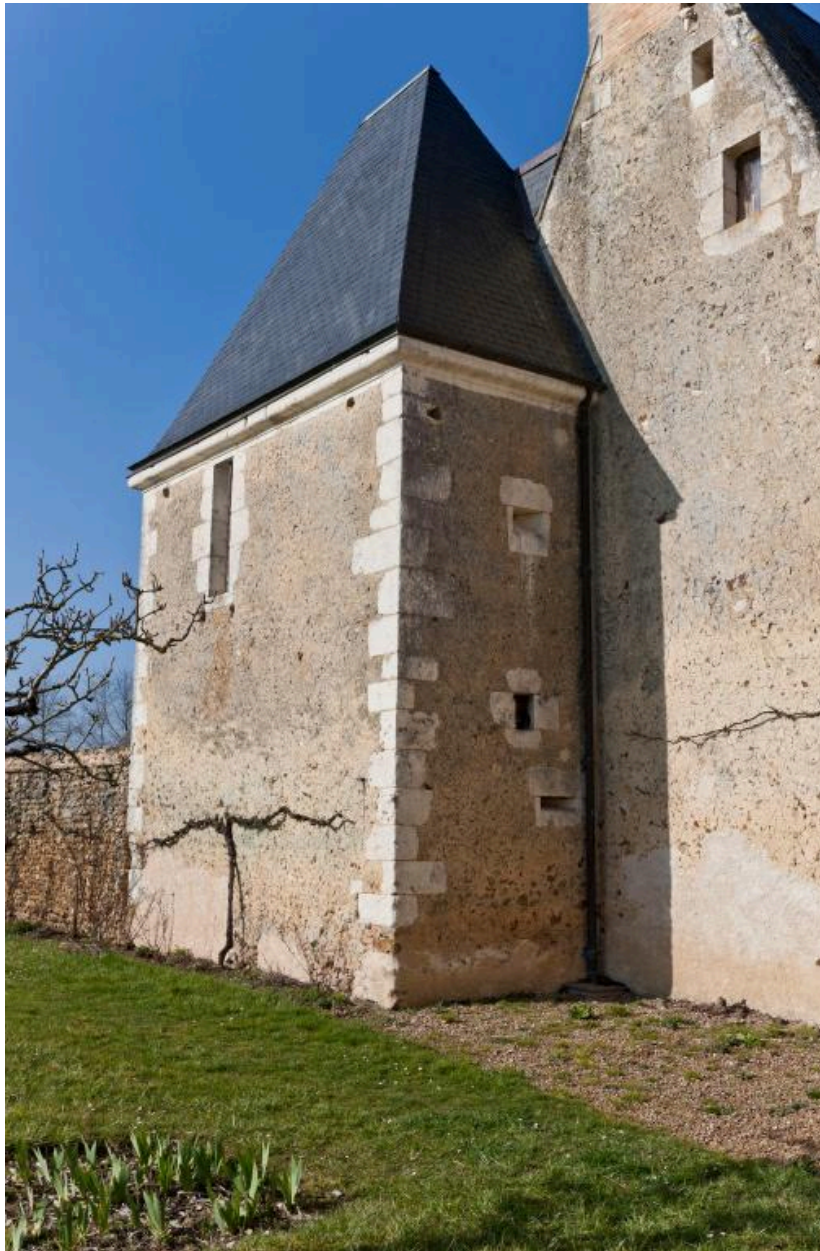
Pavillon d'angle sud-est vu de volume, par l'arrière.
