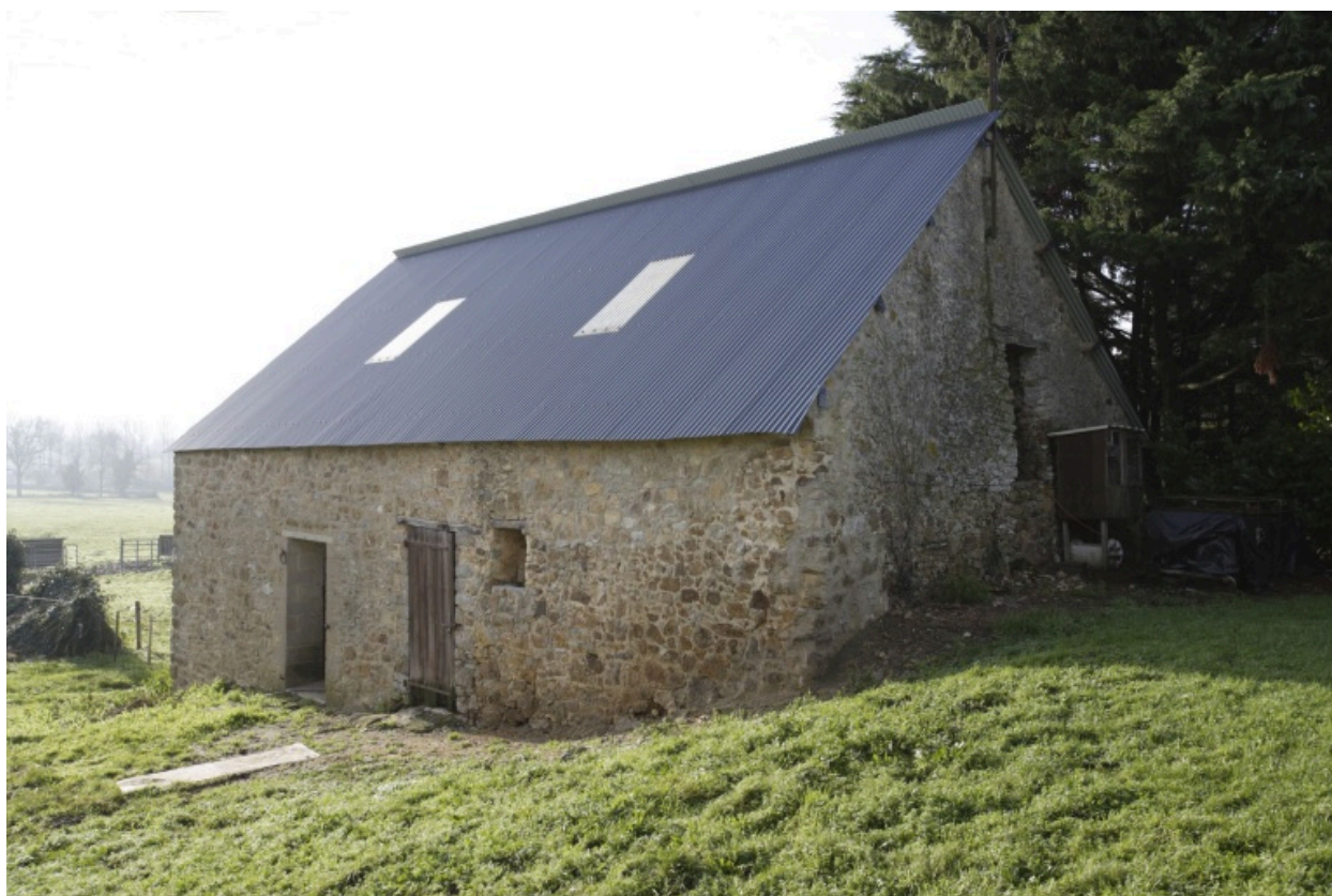
L'étable ouest vue depuis le nord-est.
