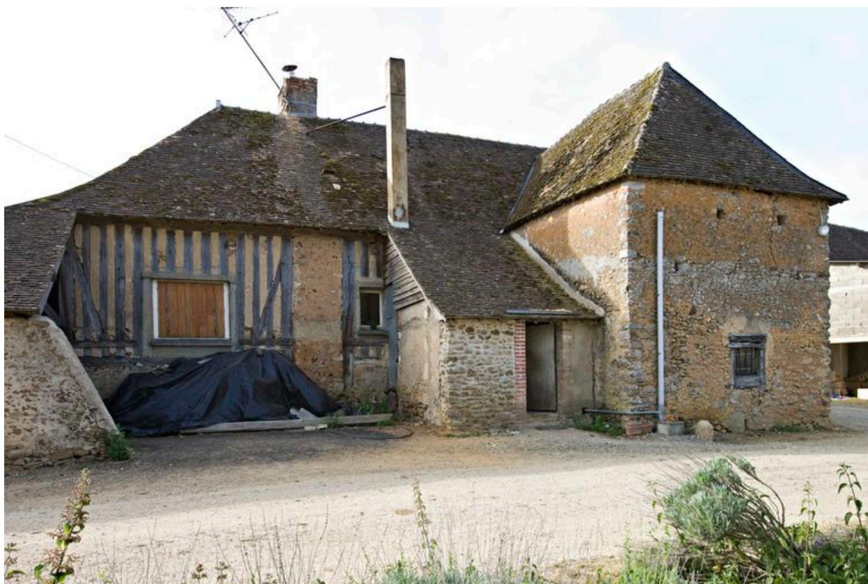
Elévation postérieure du logis.
