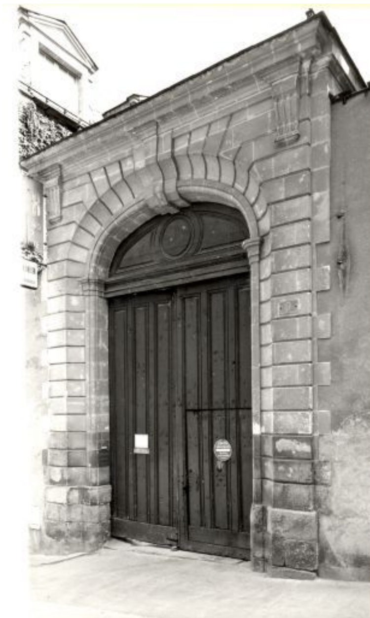
Portail, élévation antérieure.
