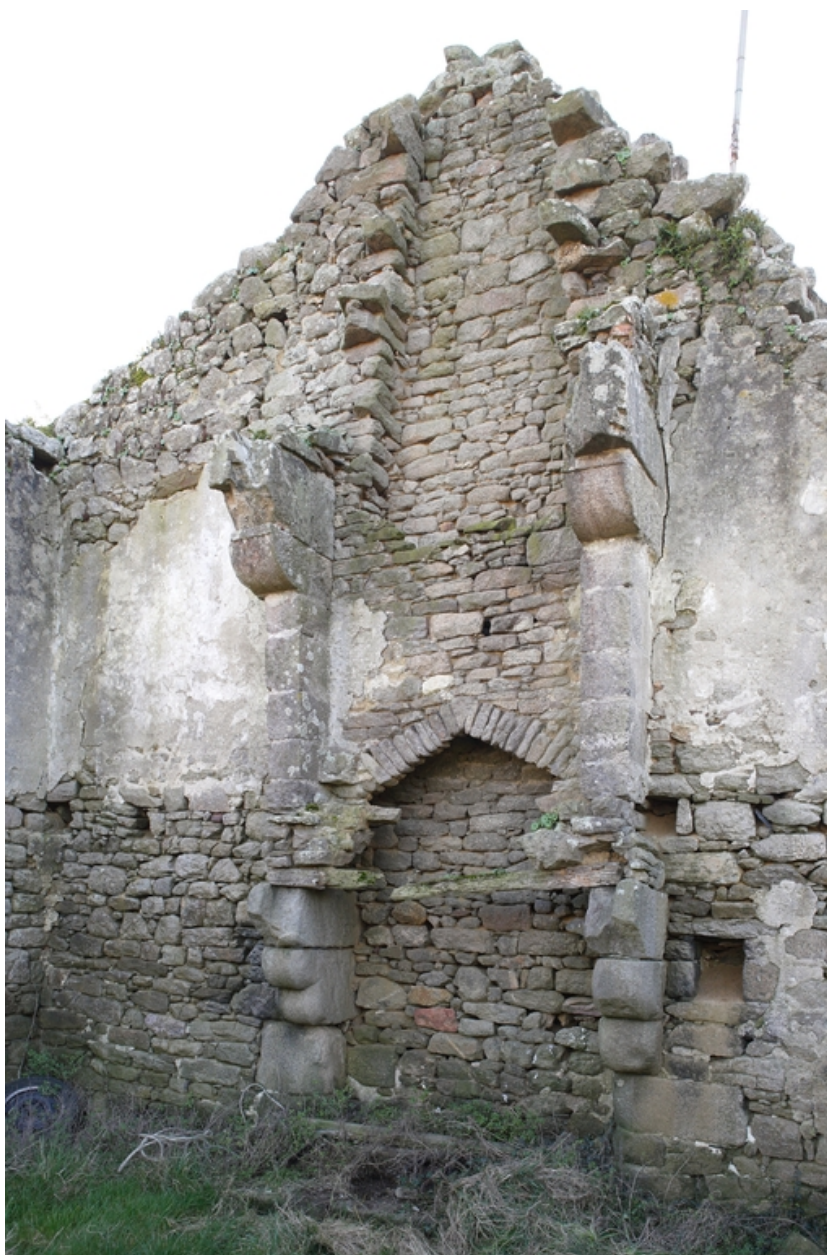
Vue des cheminées superposées du deuxième logis.
