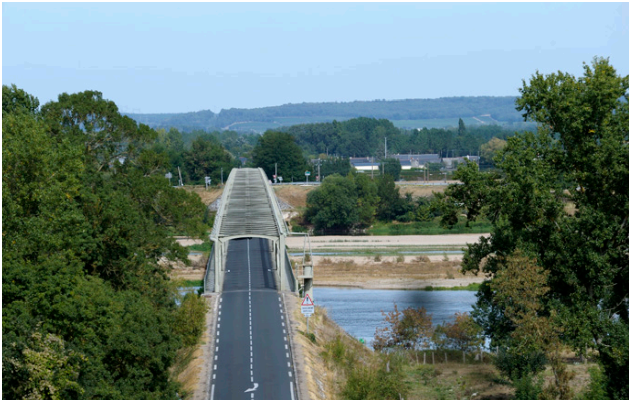
Vue générale depuis le coteau.
