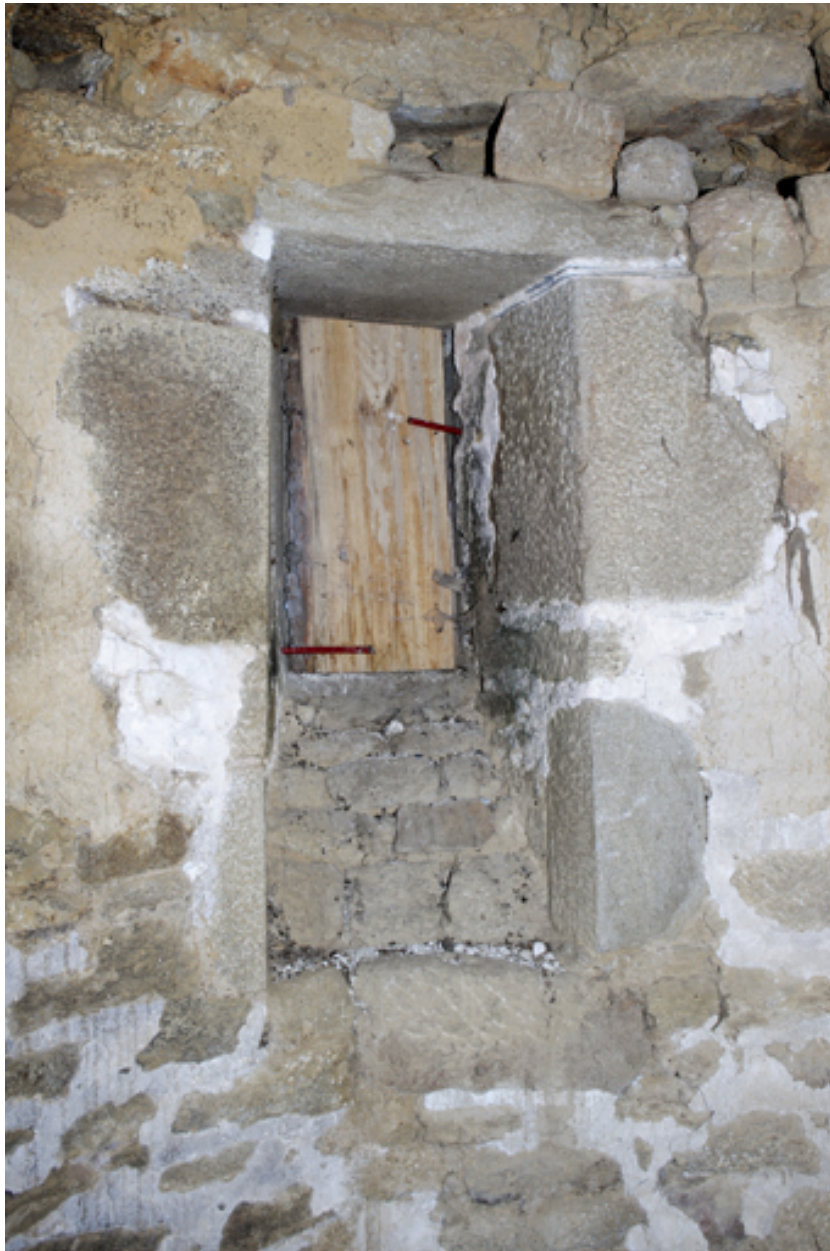
Logis. Tour d'escalier. 3e niveau. Jour d'éclairage.
